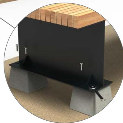
5. Recouvrez la base en béton et la plaque de base avec de la terre et finissez la chaussée.
